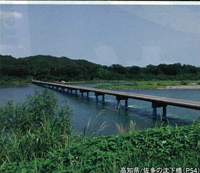
高知県/佐多の沈下橋 (P54)
